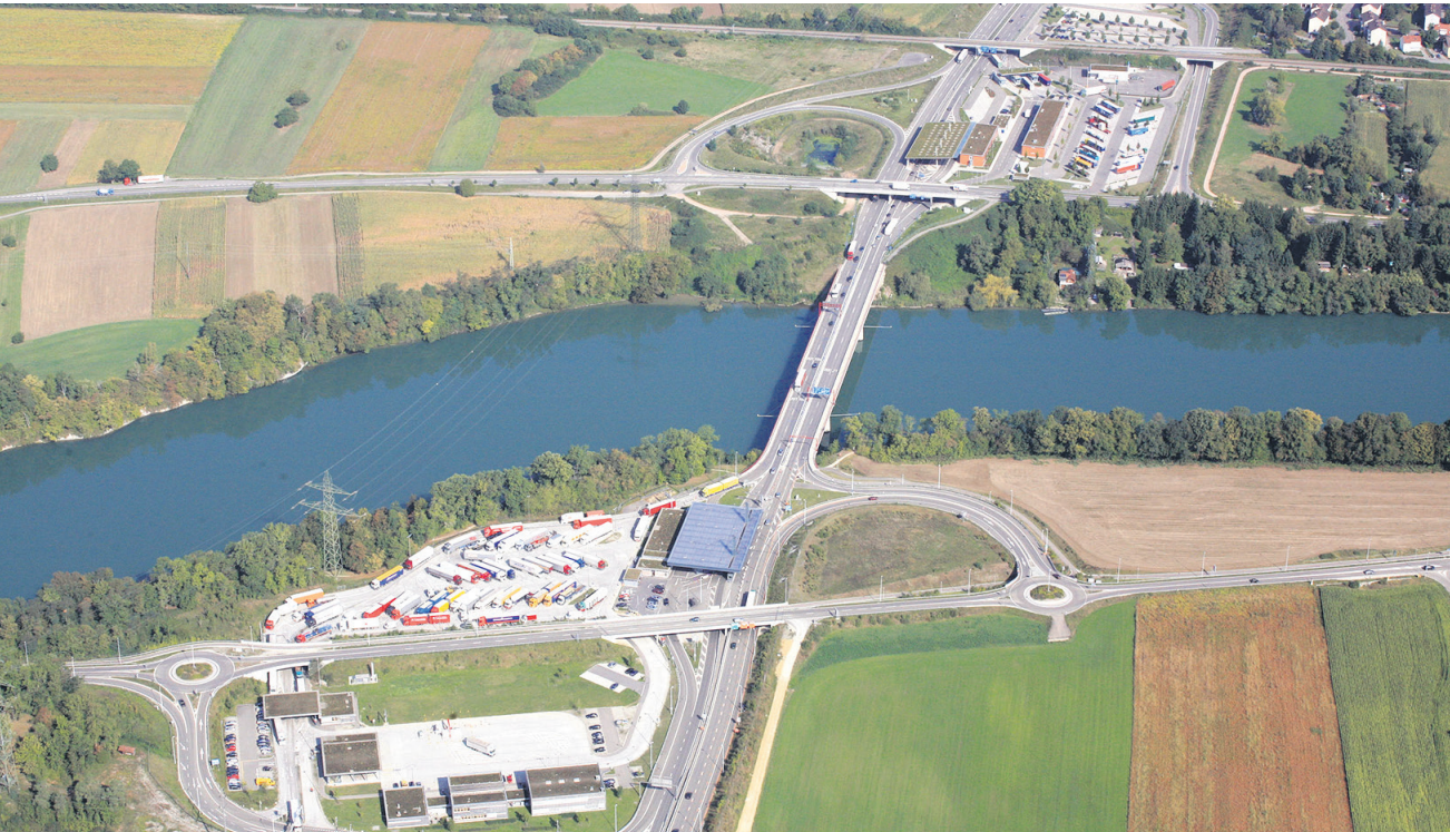
2006 ist die neue Brücke in Rheinfelden eingeweiht worden. 2019 wurde sie im Durchschnitt von täglich rund 33 000 Fahrzeugen genutzt. Die Belastung wird weiter steigen. Foto: Archiv NFZ
